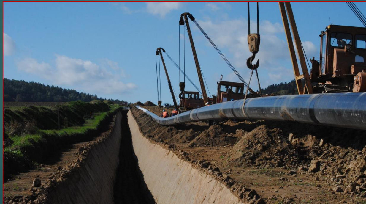
Układka w wykopie gazociągu DN1000
