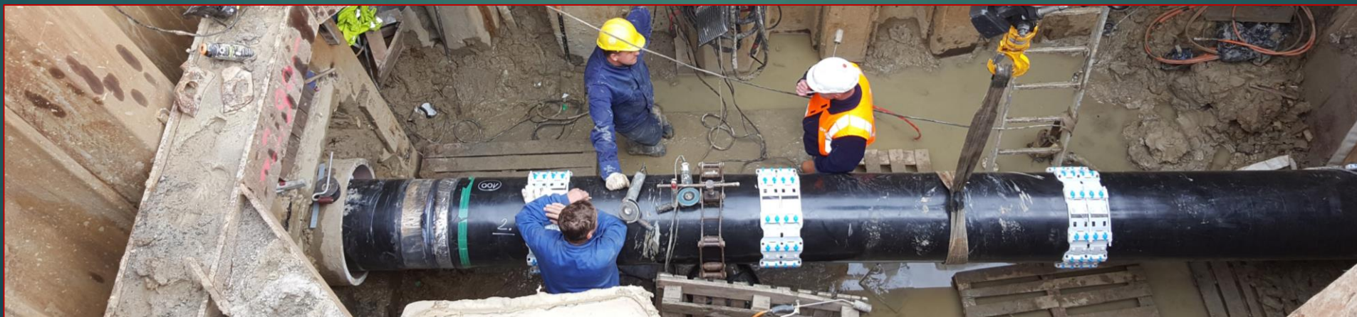
Zabudowa gazociągu DN 700 w rurze osłonowej, pod drogą krajową.
