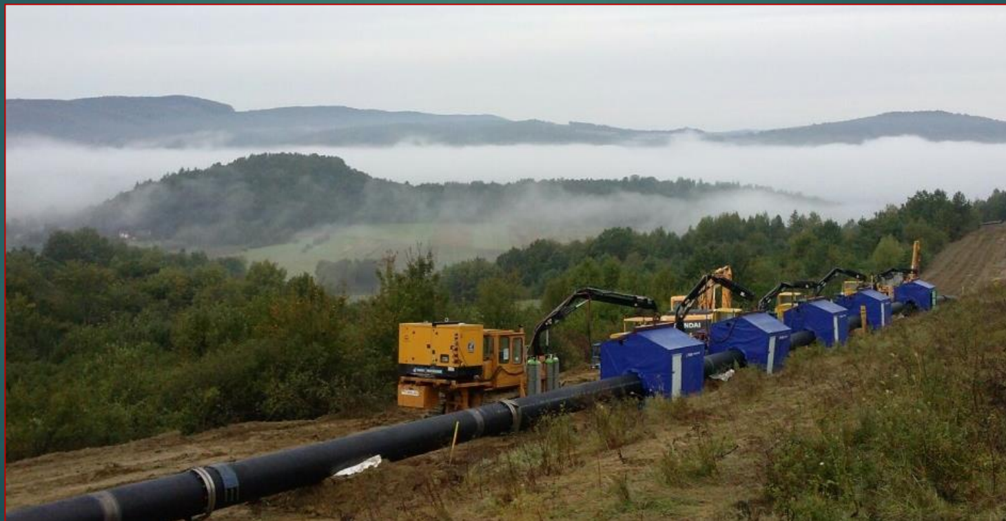
Czołówka spawalnicza na budowie gazociągu DN700/8,4MPa w warunkach górskich
