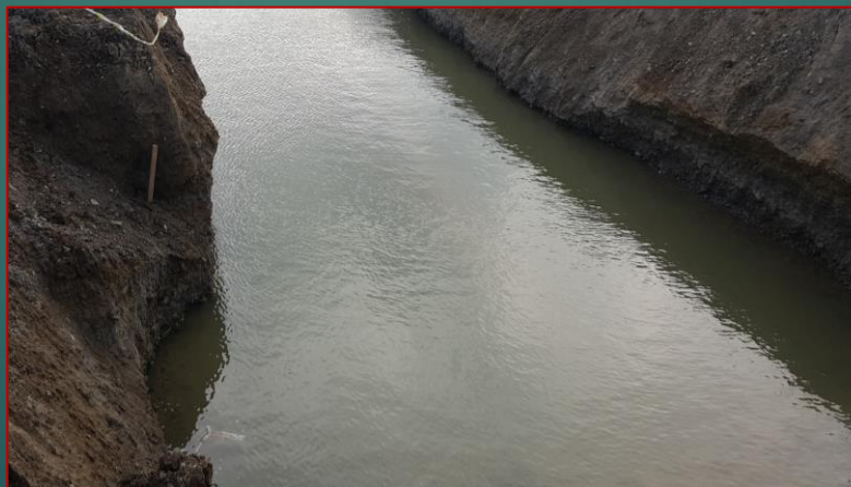
Budowa gazociągu DN700/8,4MPa w gruncie o wysokim poziomie wód gruntowych
