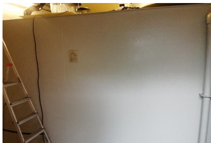
Zbiorniki na deszczówkę
